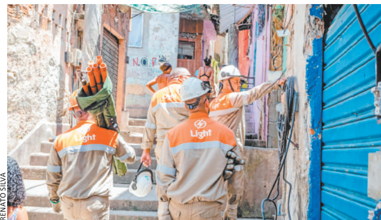
Na falta de luz e de sinal, a Associação de Moradores é a ponte entre a favela e a Light
