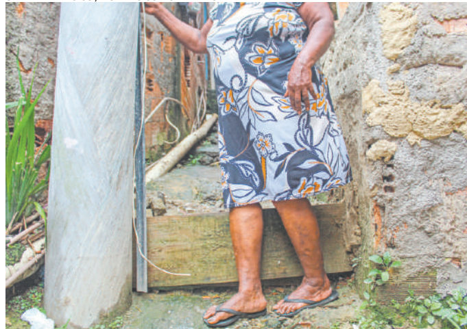
Degrau no Beco da Mamona tem quase 50 centímetros de altura e dificulta a passagem dos moradores
